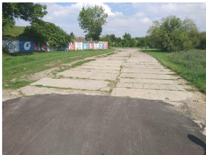
Fot. 4 – Droga z płyt betonowych do rozbiórki
